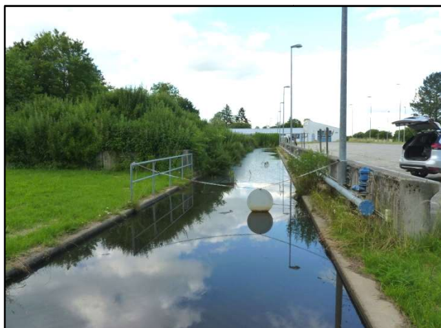
Abb. 15 Absetzbecken in der neuen Fahrzeugwaschanlage.
