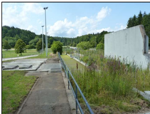
Abb. 16 Absetzbecken der ehemaligen Fahrzeugwaschanlage.
