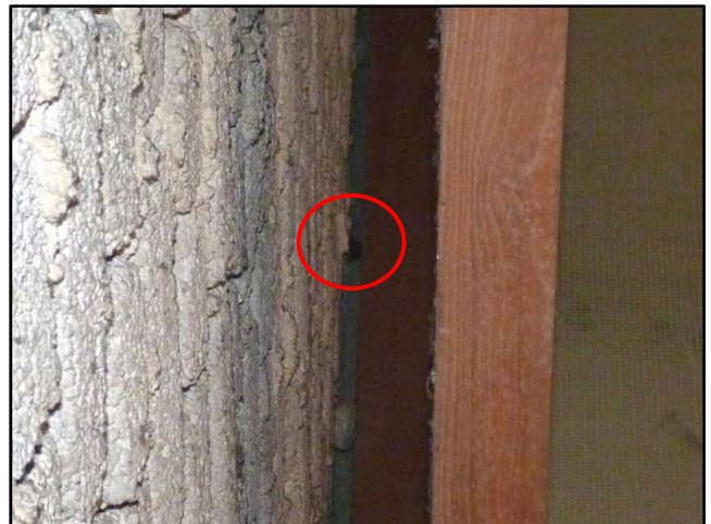
Abb. 14 Fledermaus in Spalte zwischen Wand und Balken.
