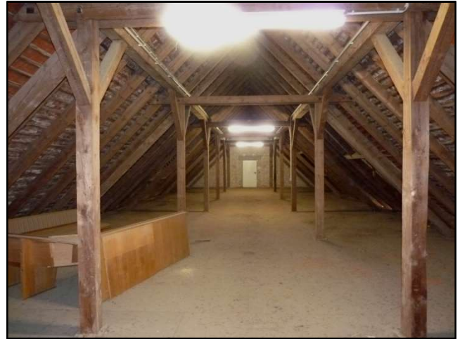
Abb. 12 Dachboden über dem Wirtschaftsgebäude..
