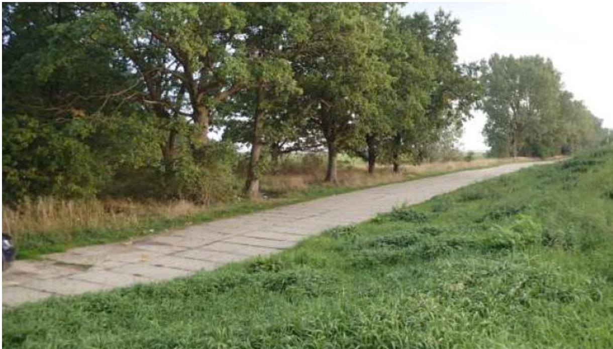
**Abb. 13: Vorhandener Weg aus Betonplatten**
