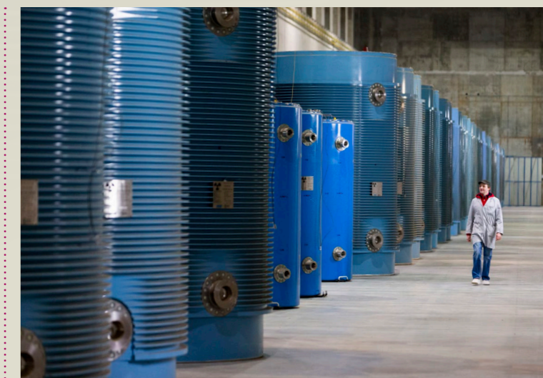
Halle 8 im Zwischenlager Nord
