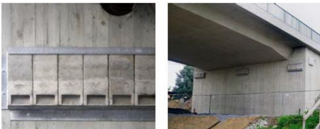
Fassadenröhren an einem sanierten Brückenbauwerk | Fotos: Thomas Frank
