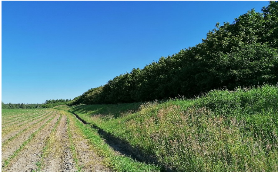
Abb. 1: Randbereich des Bodenlagers Beldorf
