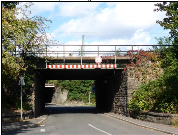
Bild 1 EÜ Bestand, Stahltrogbrücke
