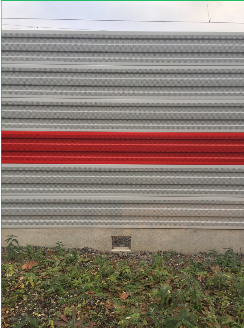
Abb. 3: Beispiel für einen Kleintierdurchlass im Sockel der Schallschutzwand
